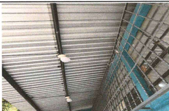
Foto 3. instalacion de vidrios nuevos y colocacion de balcones en los ventanales.
