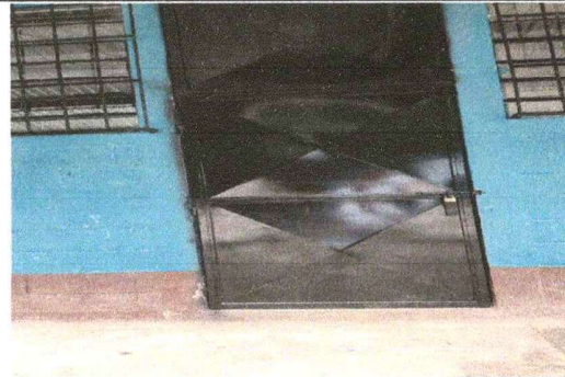
Foto 6. Mantenimiento de puerta, remocion de oxido y aplicacion de pintura.
