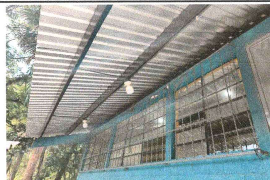
Foto 4. Instalacion de cable y accesorios nuevos para servicio de energia electrica.
